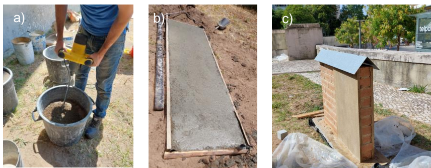
Figura B-1 – Construção de paredes: a) produção de argamassas; b) fundação fresca; c) parede terminada
