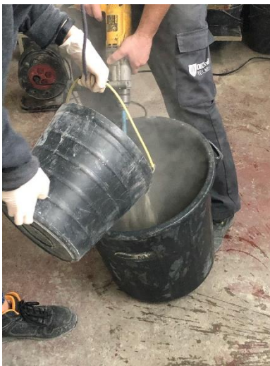
Figura 4 – Produção de PO em recipiente de 50 litros e utilizando berbequim misturador
