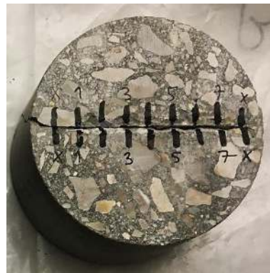
Figura 39 - Marcação para medição da penetração dos cloretos
